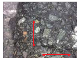
■ 現場コア写真(垂直貼り)
