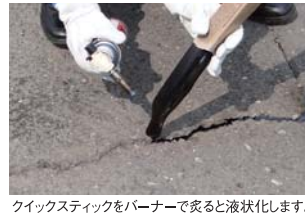
クイックスティックをバーナーで炙ると液状化します。
