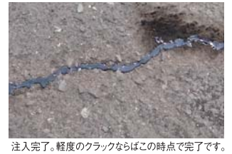
注入完了。軽度のクラックならばこの時点で完了です。
