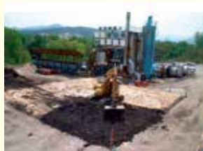
油が含まれた土壌の改良
