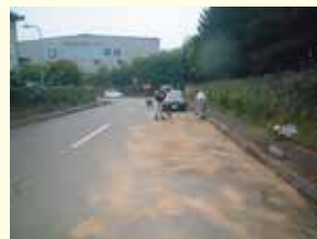
オイルを吸着したオイルゲーターを回収している状況。
