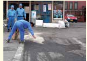
舗装面へこぼれた油の除去
