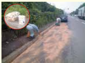
飛散したオイルにオイルゲーターを散布し、オイルを吸着させている状況。
