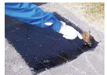
2.補修箇所にプライマーを塗布します。
