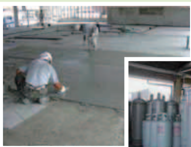
工場・倉庫床
