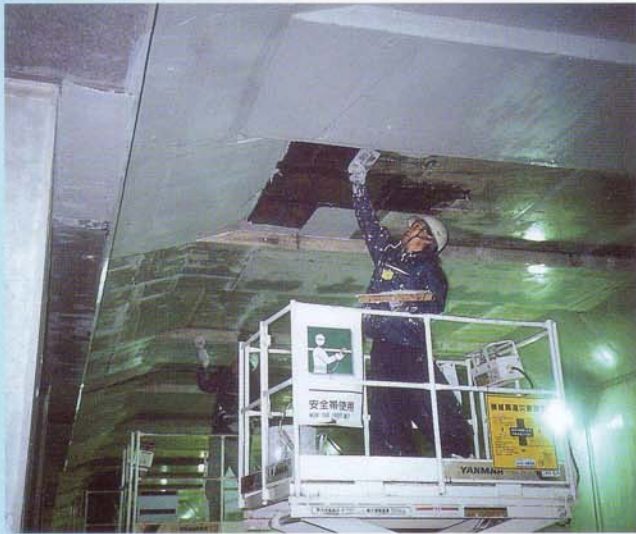
地下構造物防水
