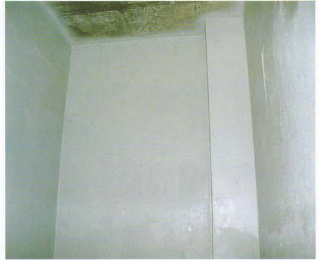
防火水槽防水
