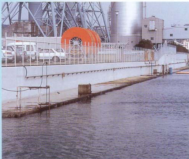
コンクリート保護防水及び美装
