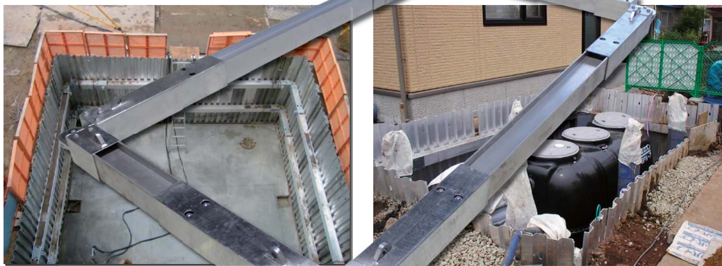
エレベーター基礎工事 (W5115×L5600×H2550)
