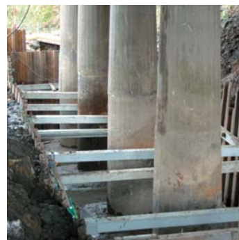
橋梁耐震補強工事
