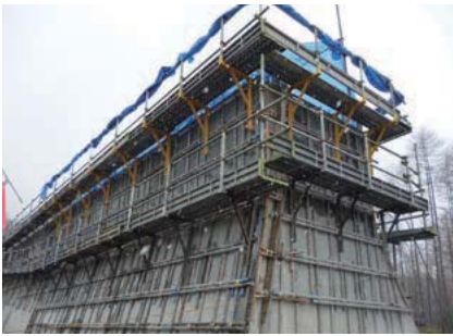
砂防堰堤工事
