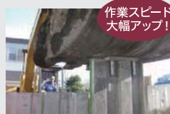
作業スピード大幅アップ! 矢板を打ち込む際に、先端が変形しないように使用する工具です。 ※軽量鋼矢板1型/2型にも使用できます。
