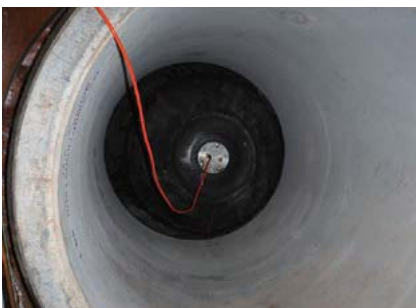
マンホール内補修工事
