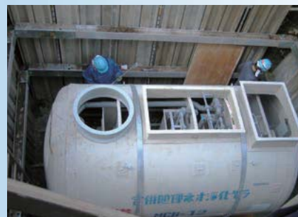
浄化槽埋設工事
