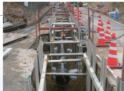
ガス管敷設工事
