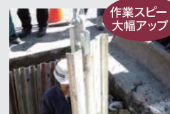
作業スピード大幅アップ! 撤去時の引抜作業が行え、矢板先端や引抜穴を保護します。 ※HAY3833N 専用
