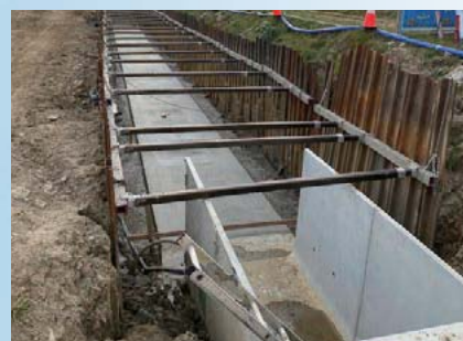
河川改良工事
