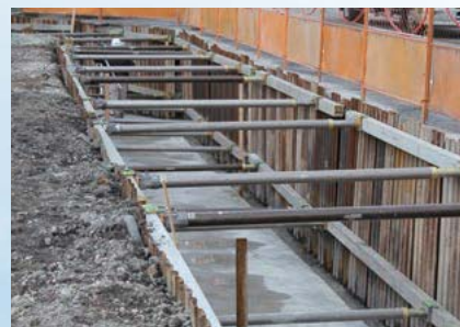
拡張用地整備工事
