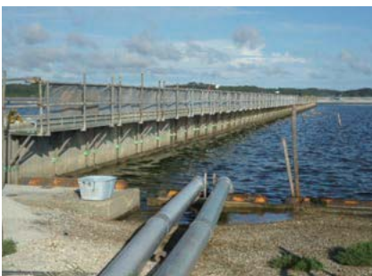
護岸かさ上げ工事
