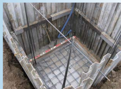
浄化槽埋設工事
