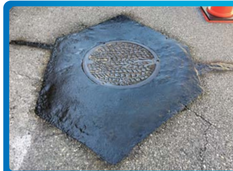
② マスチックワン敷き均し
