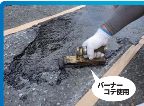
① マスチックワン敷き均し ② プライマー塗布
