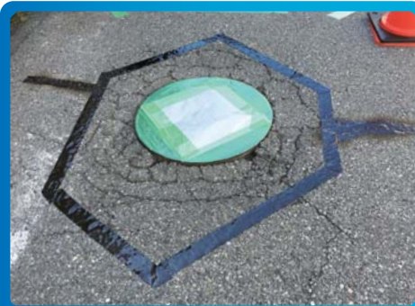
① 養生テープ・クイックシール貼付け
