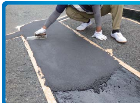
③ マスチックワン強化保護材 ④ 養生
