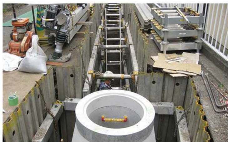
下水道管設置工事
