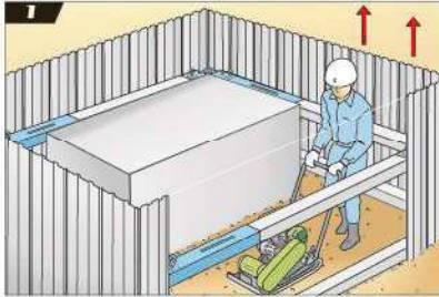
1 下段のつっぱり名人下まで埋め戻しを行い矢板を引き上げ転圧を行います。
