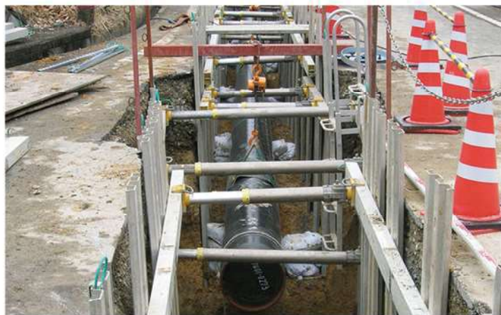
ガス管敷設設置工事
