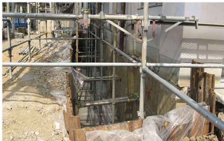
耐震補強工事
