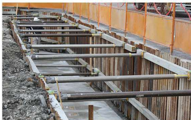
拡張用地整備工事
