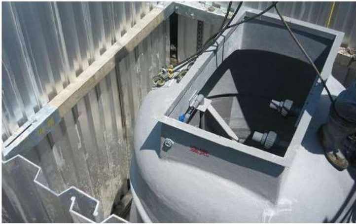
浄化槽(コンパクト型)埋設工事
