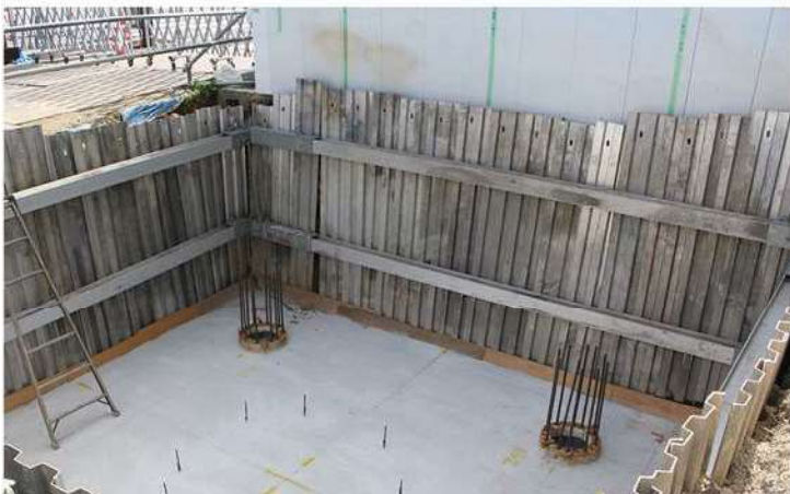
歩道橋新設工事
