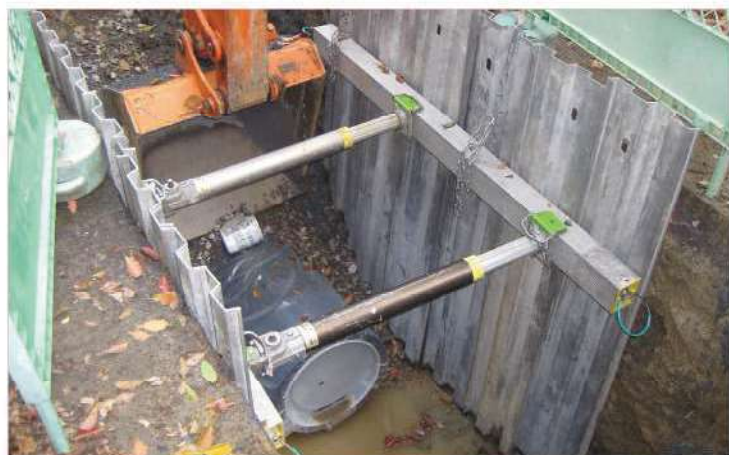
上水道管布設替工事
