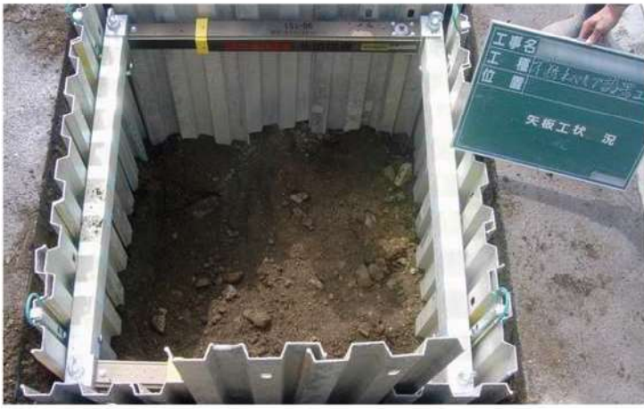
不断水バルブ設置工事
