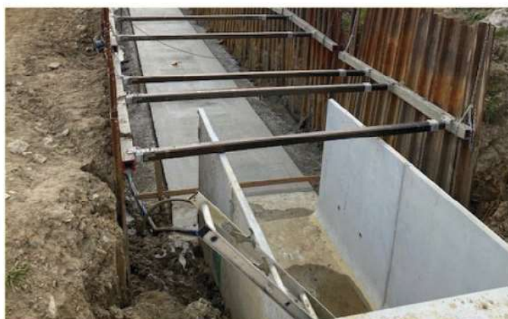
河川改良工事
