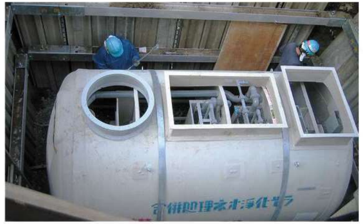
浄化槽埋設工事
