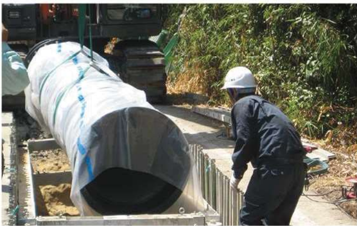
上水道管敷設工事
