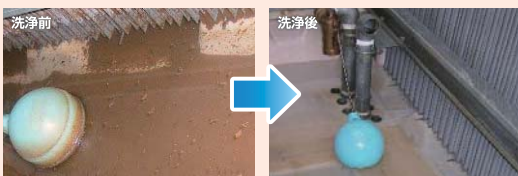
クーリングタワー洗浄施工事例
