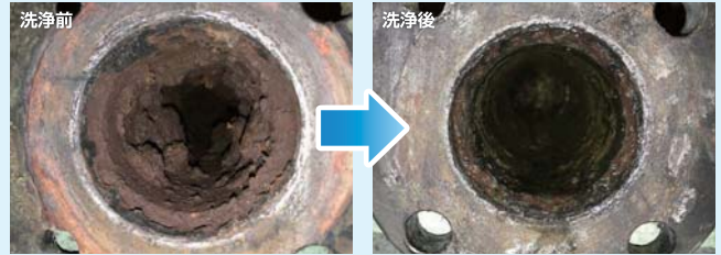
鉄さびスケール洗浄施工事例
