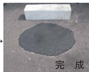
③打設敷均し (付属コテ使用)
