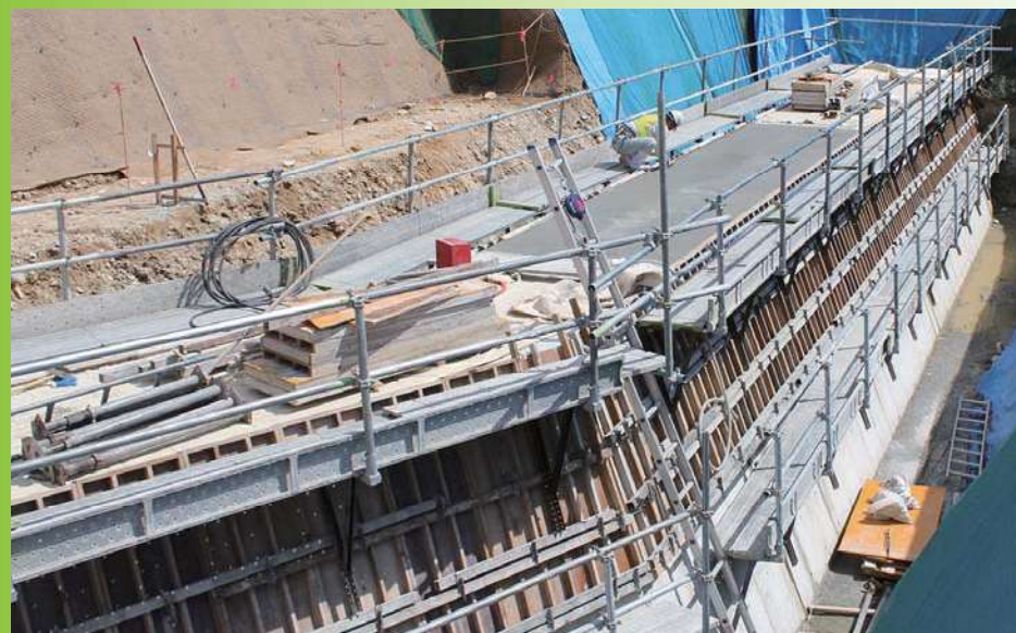
アルウォーク足場施工現場
