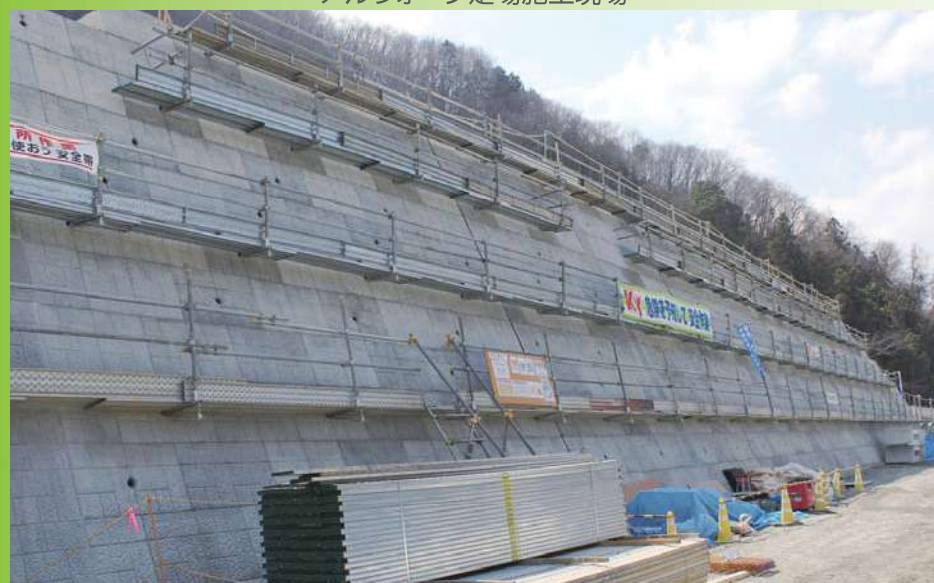
水抜きパイプ足場施工現場
