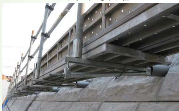
水抜きパイプ足場
